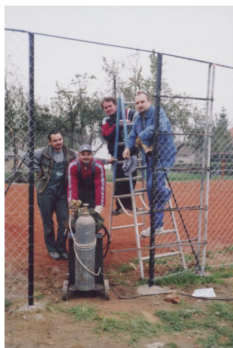
Izgradnja teniskog igrališta
